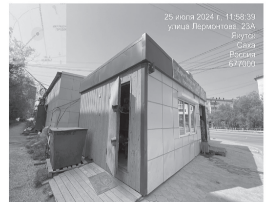
Фото 3: Вид на неправомерно размещенный павильон по адресу: г. Якутск ул. Лермонтова 23 А
